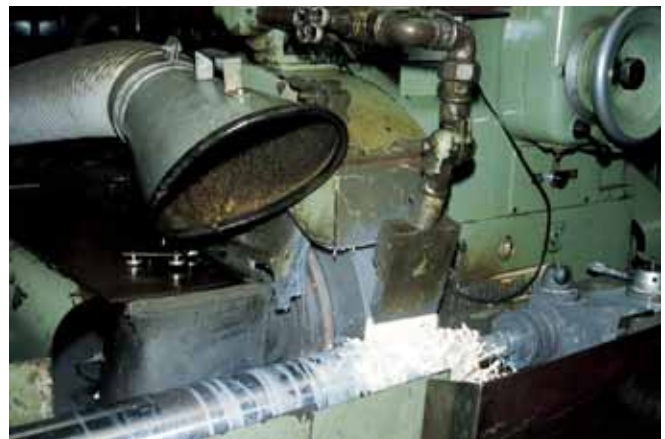
Abb. 11: Absaugung von Kühlschmierstoffemissionen an einer Rundschleifmaschine
